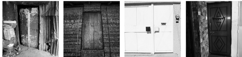
Figura 43. Puertas de madera
